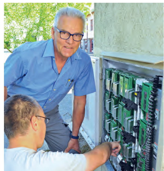
Sepp Zumsteg, Leiter der Abteilung Leitungsbau, besucht sein Team auf der Baustelle Zeiningen und begutachtet die erledigten Arbeiten.
