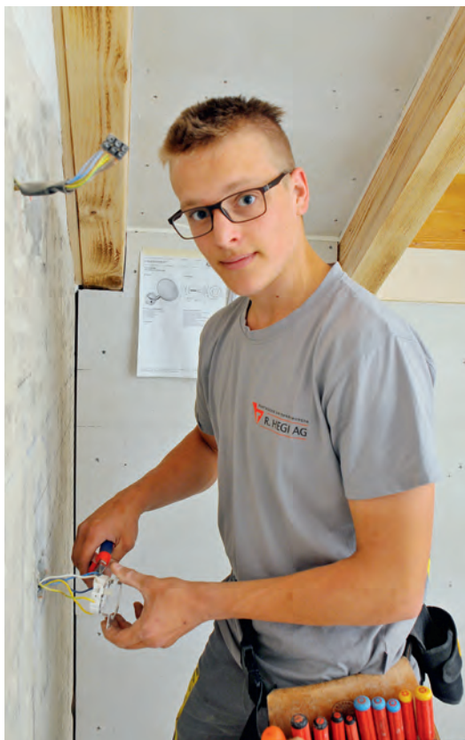
Aufspitzen, bohren, verlegen und montieren: Es wird umgebaut. Nils Bischof und Gideon Erni passen die elektrischen Installationen an.
